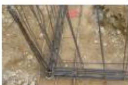
Nœud de chaînage - Continuité mécanique
